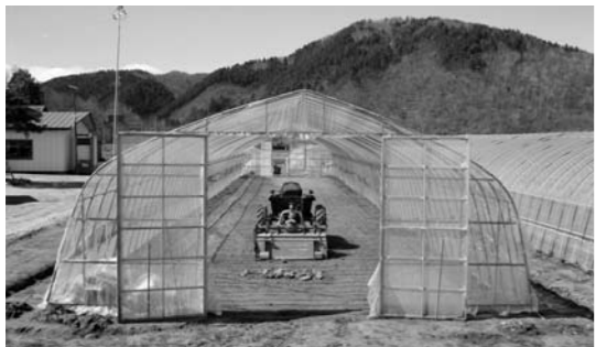
農業元気づくり事業で設置したハウス（幾寅地区）
